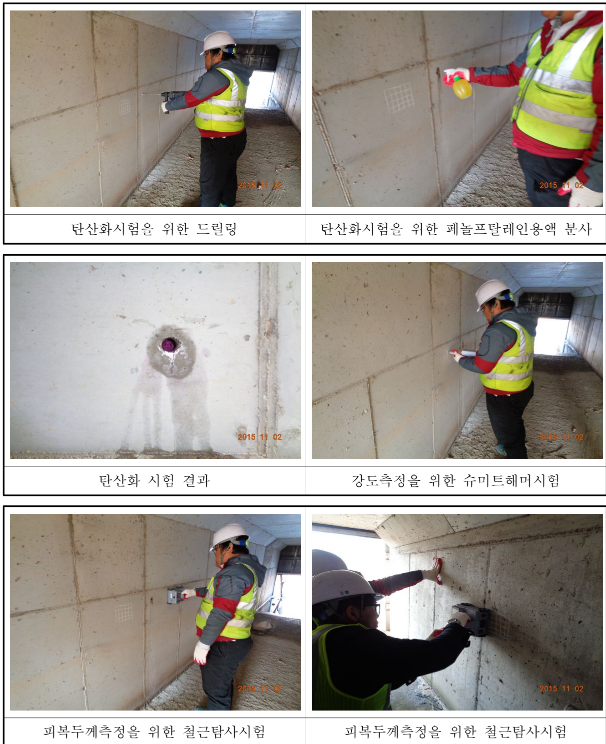
【사진 Ⅱ.1-5】 시험 및 측정 전경
